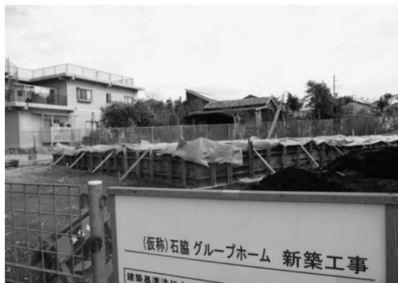
建設中のグループホーム（石脇）
