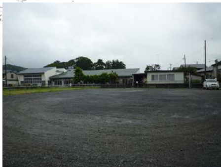
⑤敷地南側 送迎用駐車場(借地)
