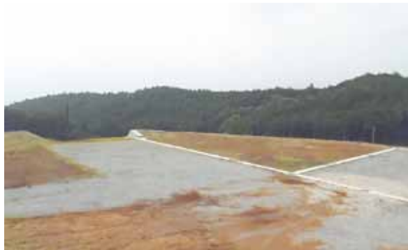
管理棟建設予定地
