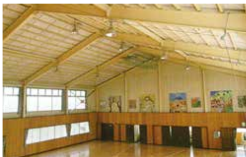
▲富岡第二小学校体育館
