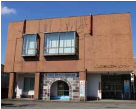
◀ 深良地区コミュニティセンター改修事業(耐震改修を行う深良地区コミュニティセンター)
