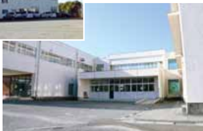
東小学校（昇降口棟）▶
