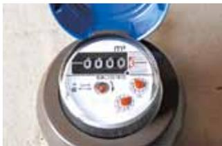
各家庭・事業所などに取り付けられた水道メーターは、計量法に基づき8年に一度無料で交換しています。該当する方には、事前に通知し、市の委託水道業者が交換に伺います。交換作業中は、断水などのご迷惑をお掛けしますが、ご理解とご協力をお願いします。
