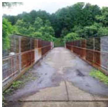
◀長寿命化の補修を行う東名跨道橋〔東名瀬戸山（Ⅰ）橋〕
