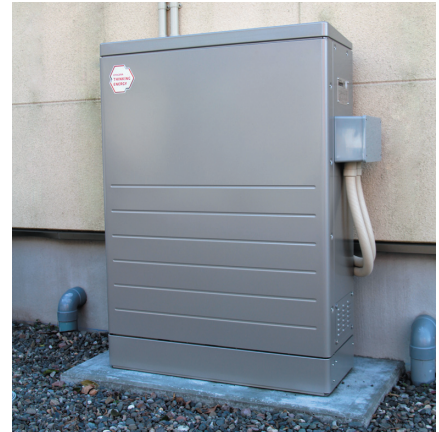
▲緊急時に電力を供給する蓄電池システム
