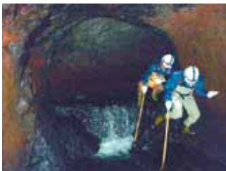
◀段差1 mの合流地点
